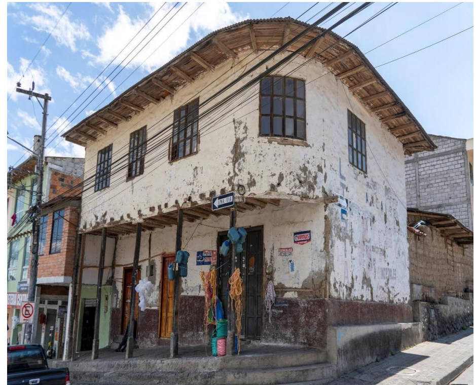
Fotografía 2.2.3-14 Situación actual de los inmuebles
